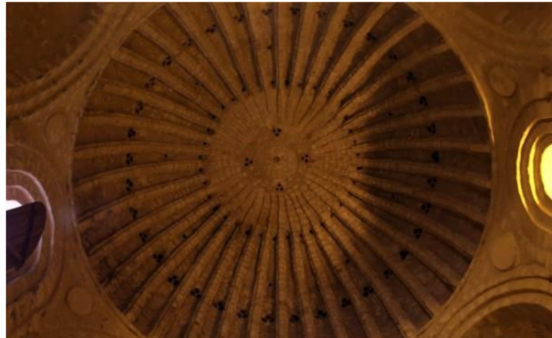
La coupole qui surmonte la salle principale du Foundouk (Source : INP-2018)
