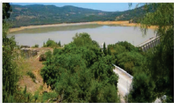
Barrage de Beni M'tir
