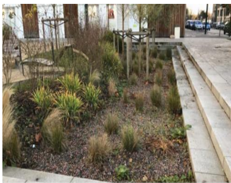
figure5 : Jardin de pluie à Palaiseau source siavb, règlement d'assainissement-2018)
