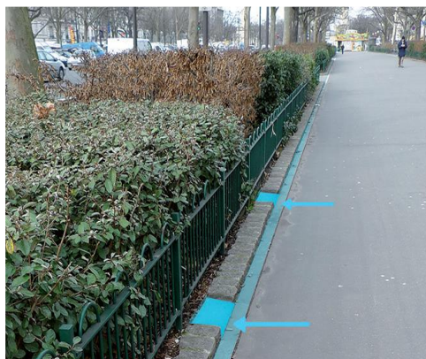
figure 12 : Reprise des bordures des jardinières et des joints des pavés existants. Contre allée du cours de Vincennes, Paris 12e . Photomontage Apur
