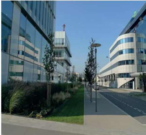
figure 10 : Noue plantée, rue Galien, Saint-Ouen (réf : pour une gestion à la source des eaux pluviales dans la métropole |APUR)
