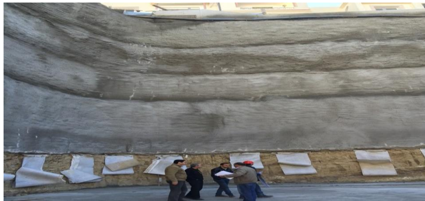
Figure 7. Vue de la paroi clouée à la fin de l'excavation de profondeur 20
