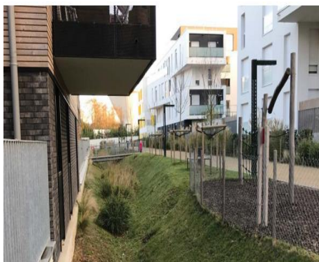
figure4 : Noue de Palaiseau source siavb, règlement d'assainissement-2018)
