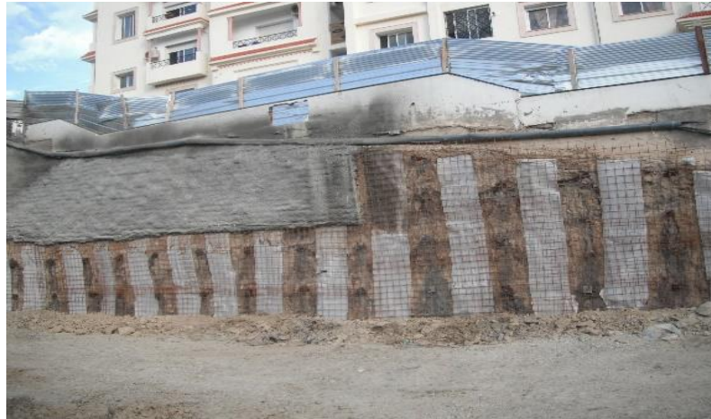
Figure 3. Vue d'ensemble de l'exécution du système de soutènement
