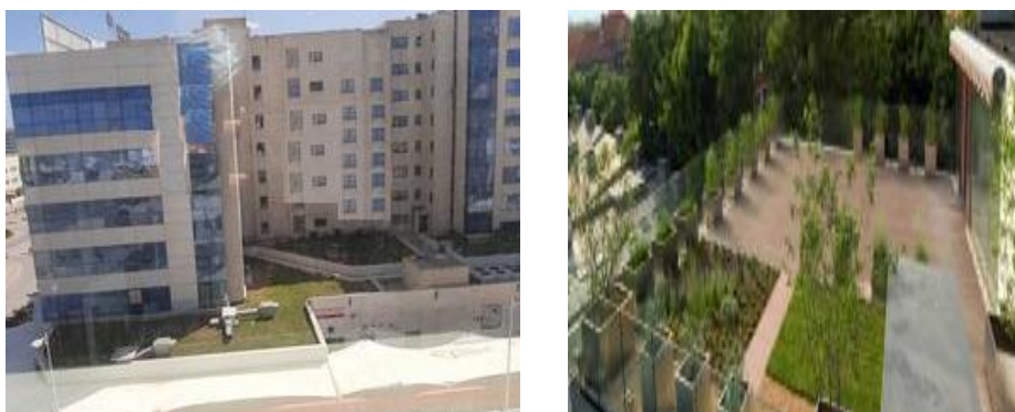
figure15 : Toit végétale (1-centre urbain Nord, 2-la Marsa)
