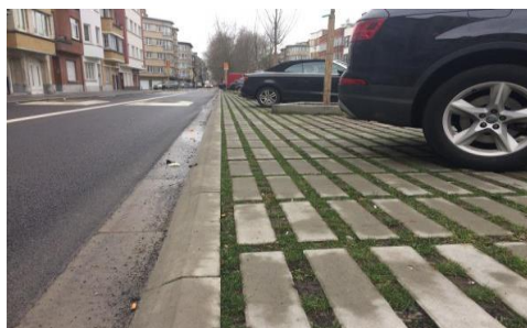
figure 7 : revêtement poreux Bruxelles (Guide Bâtiment Durable .Brussels, 2018)
